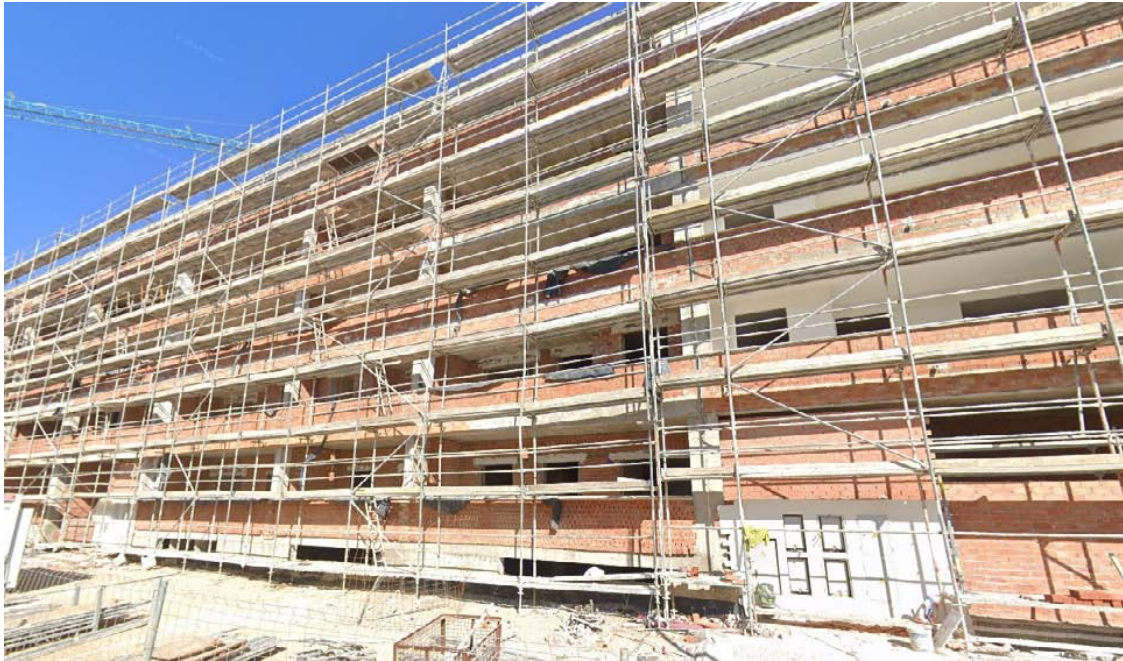
Las obras de las antigua bodega Zoilo Ruiz Mateos, en Jerez.
